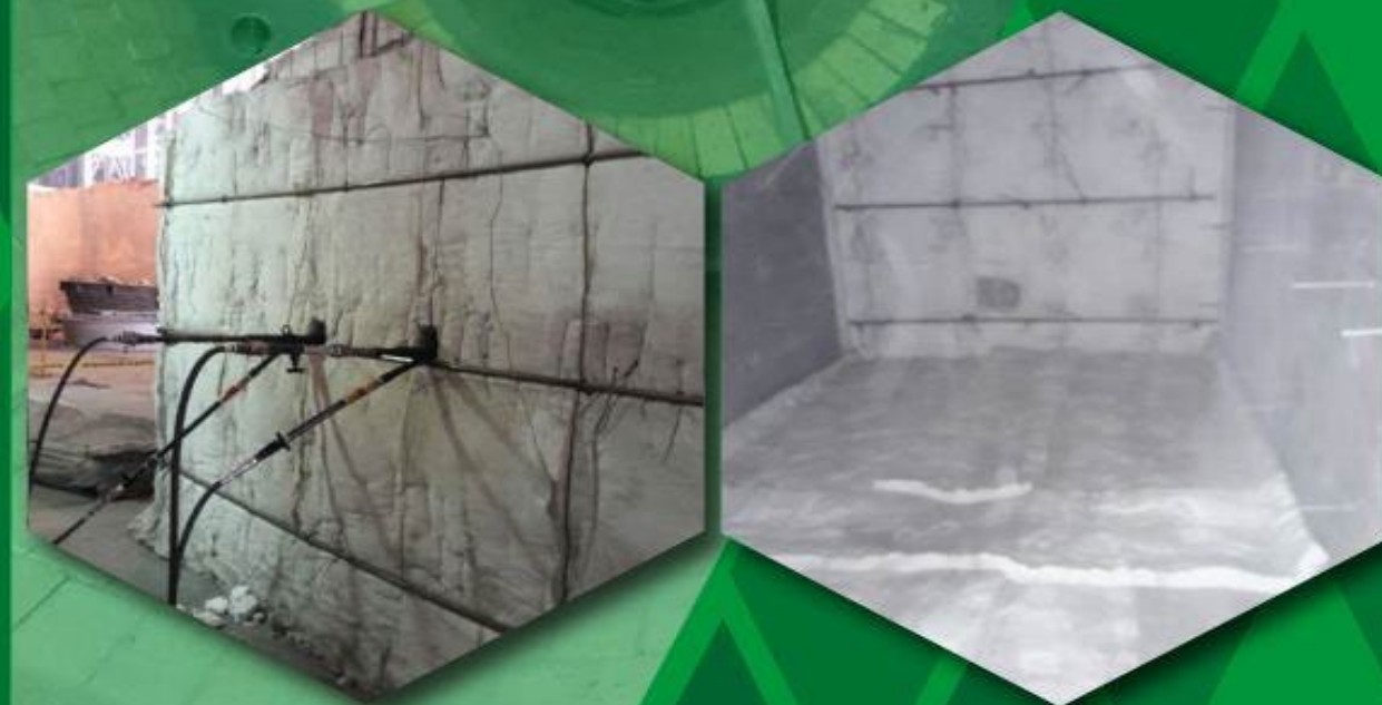
SERVICIO DE SECADO DE CONCRETO REFRACTARIO
